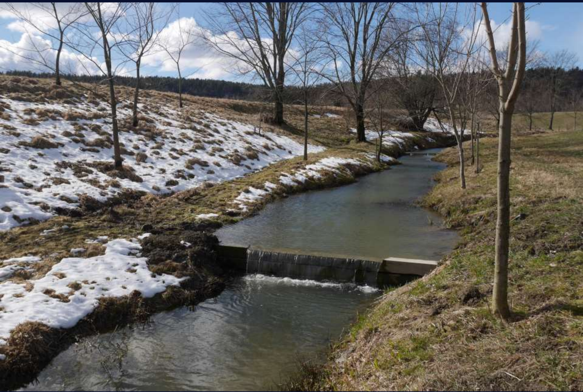
TERSKLING: FRA GRØFT TIL VANNSPEIL, SVINNINGBEKKEN, RE
